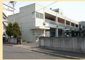
工場アパート外観
