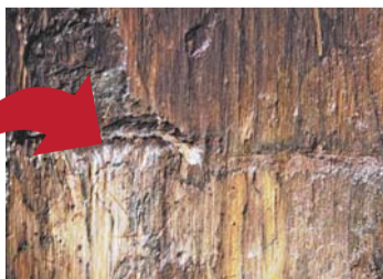
ウルシ材の杭
