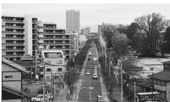
都市計画道路をはじめ都市基盤の整備を進めます(さくら通り)
