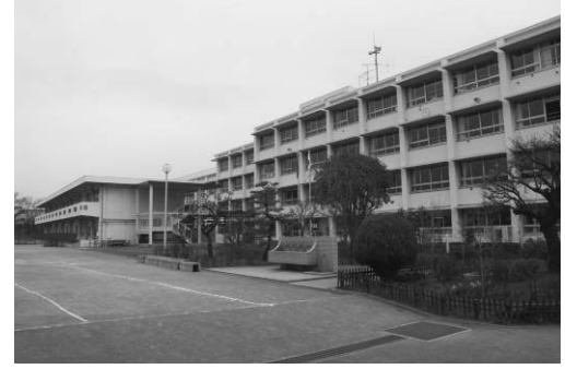
耐震補強工事が行われる第一中学校
