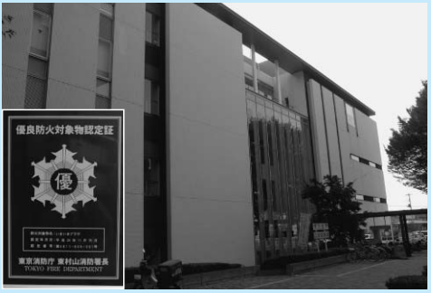
「いきいきプラザ」の外観と「優マーク」
