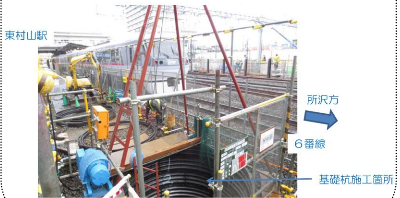
高架橋基礎杭 鉄筋組立状況写真
